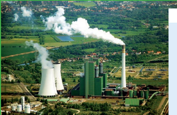
Braunkohlekraftwerk Schkopau (Sachsen-Anhalt)
